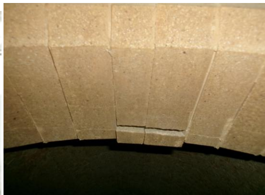
い号炉再燃焼炉下がり壁部分
