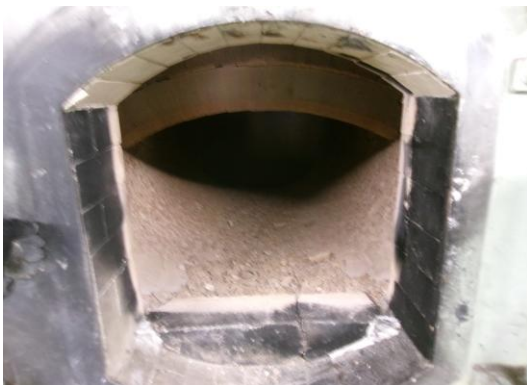
い号炉再燃焼炉点検口正面
