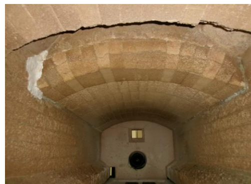
は号炉主燃炉天井アーチ部分
