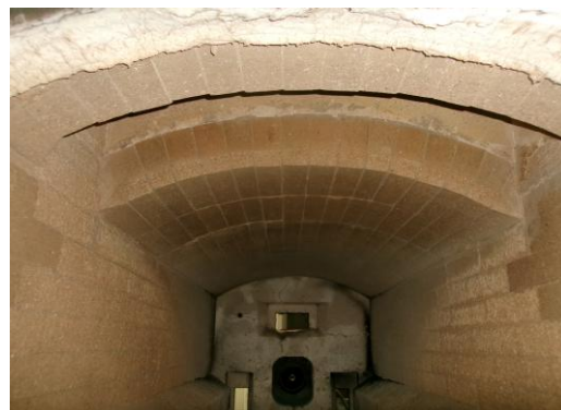
は号炉主燃炉天井アーチ部分
