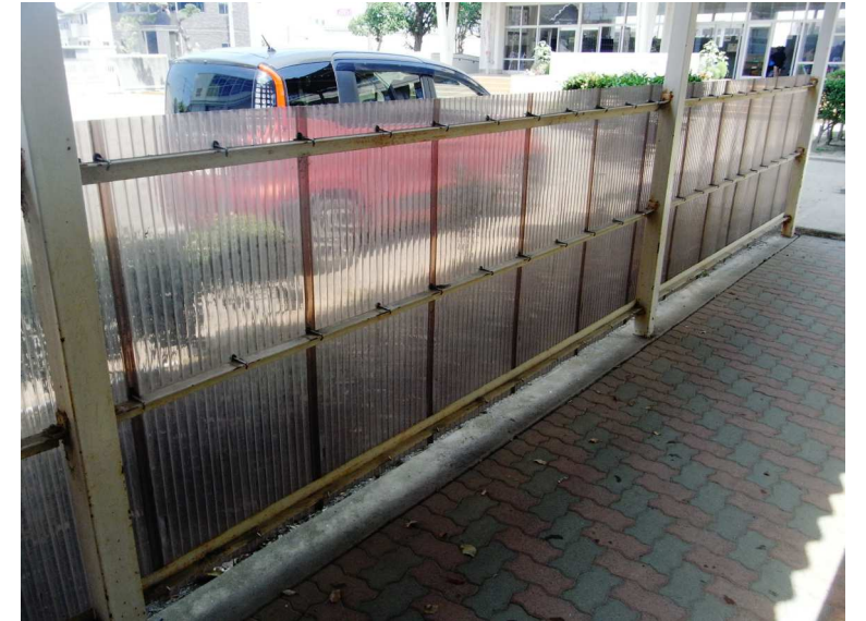
渡り廊下腰壁撤去
