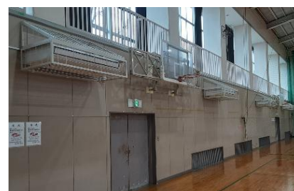
▲ 空調設備設置の様子
